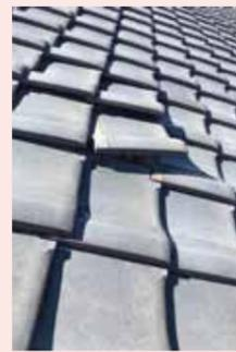
瓦のヒビ割れやズレを放置すると、雨水が浸み込み、屋根自体が腐食してしまう恐れが…早めの補修を行いましょう！
