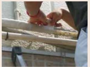
**24 エアコン配管の隙間パテ埋め**
